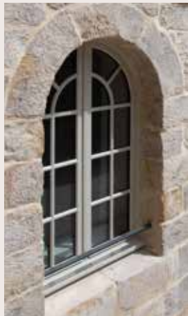
Menuiserie plein cintre avec petits bois collés
